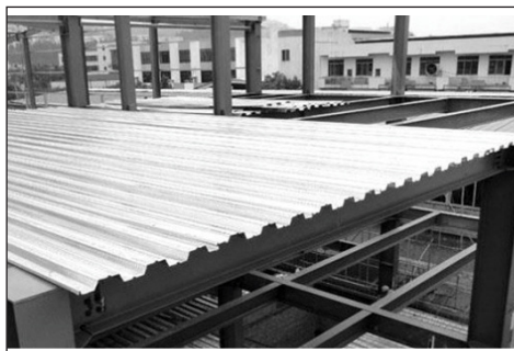
Tablier métallique et toiture métallique.
