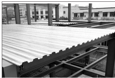
Tablier métallique et toiture métallique.
